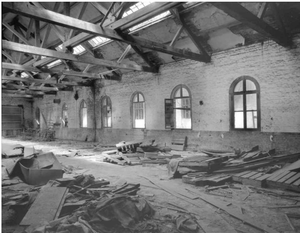
Scierie, en 1989 : vue intérieure.
