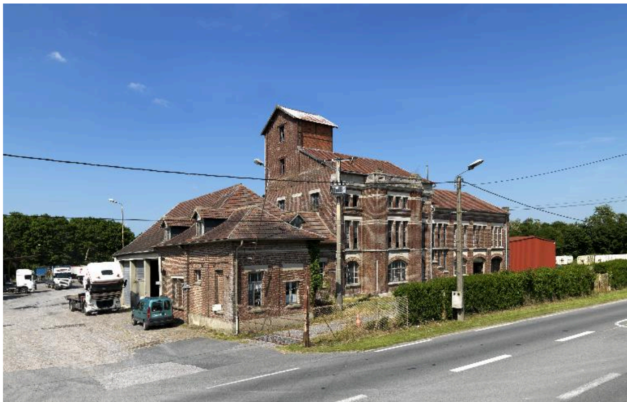
Vue d'ensemble de trois-quarts de la râperie.
