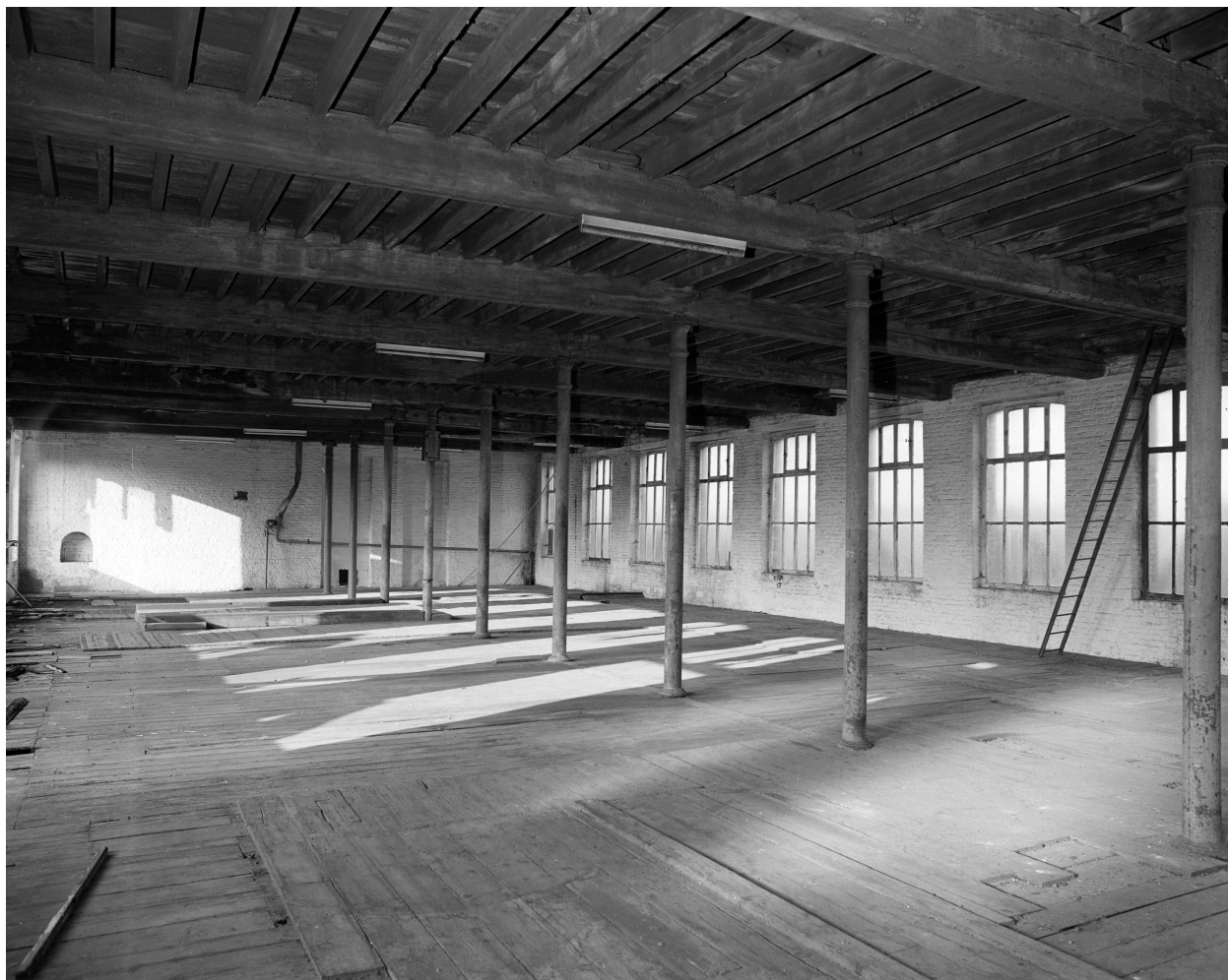
Atelier de fabrication, partie ancienne, premier étage.
