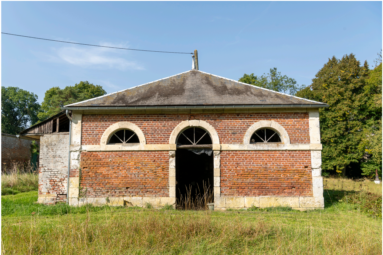
Remise et scierie abritant un puits, vue depuis le sud.
