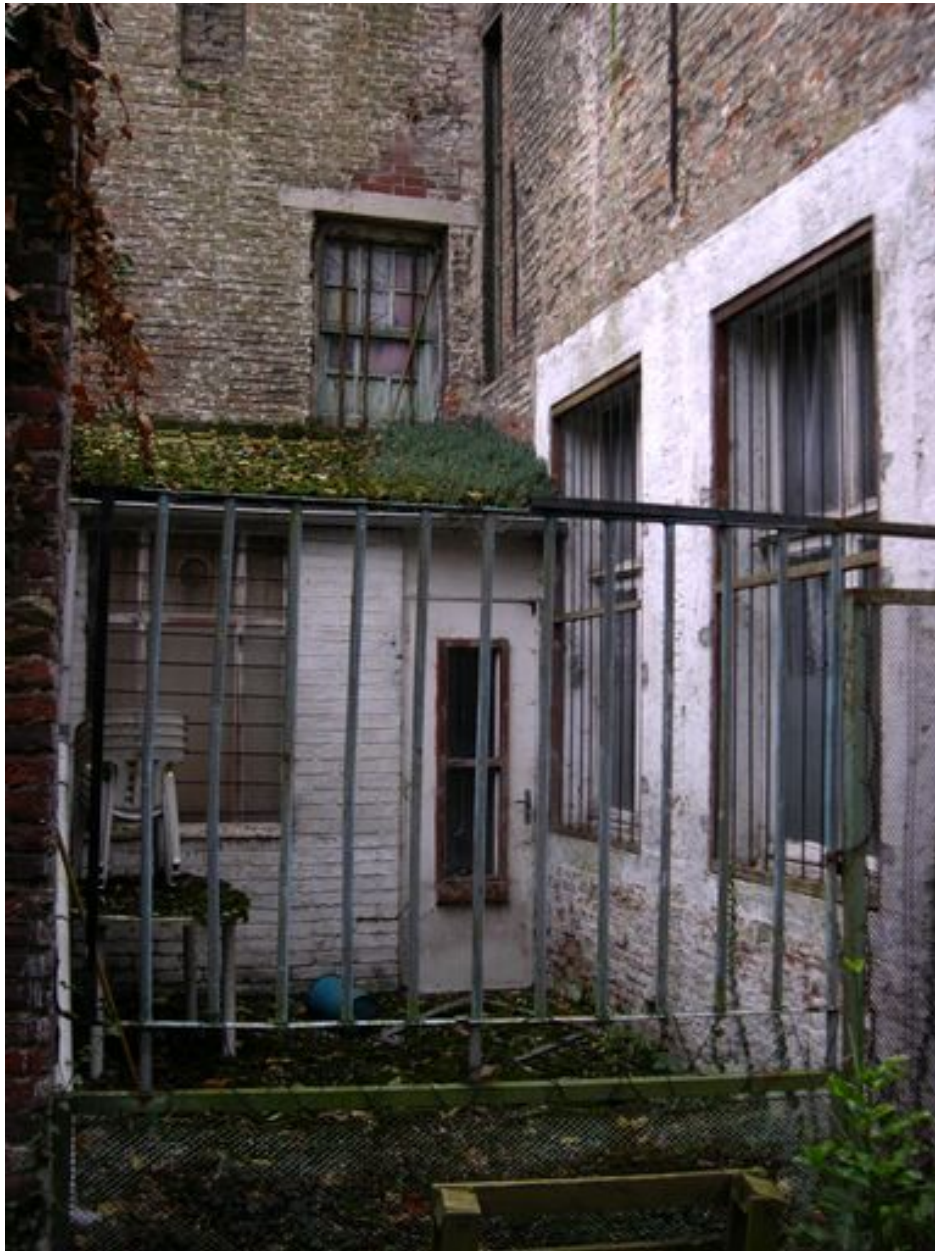
Façade arrière, vue partielle : rez-de-chausée, courette.
