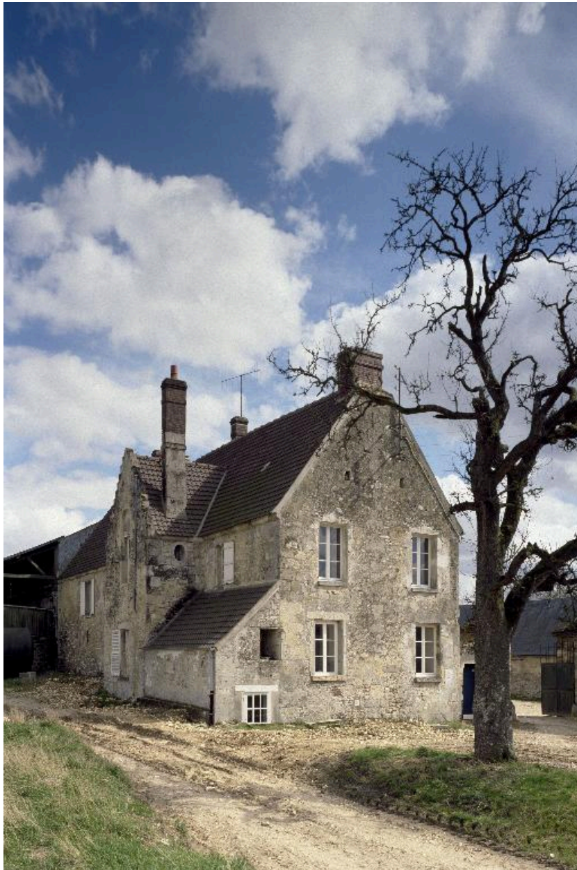
Vue générale du logis, depuis le nord-ouest.
