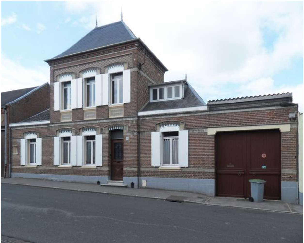
Saint-Ouen, maison, 28 rue Philippe-Louis, 2e moitié du 19e siècle.
