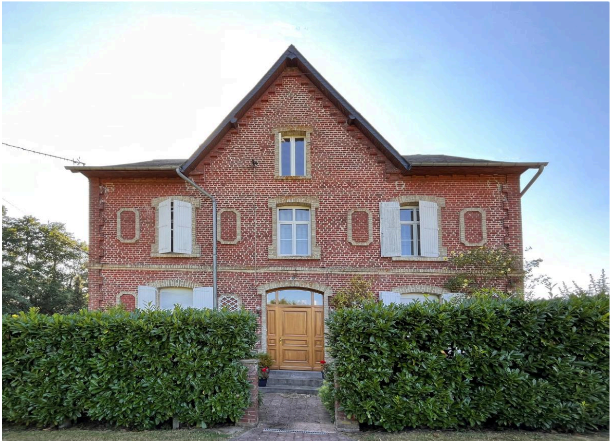
Façade sur rue de la maison de contremaître.
