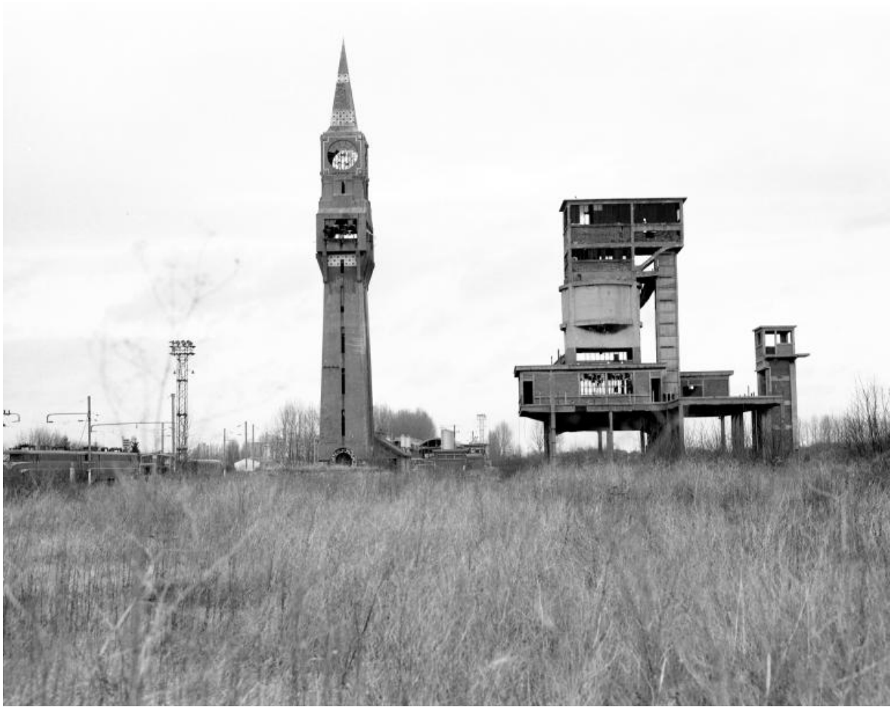
Tour d'aiguillage dite tour Florentine avec, à sa droite, le toboggan à charbon.
