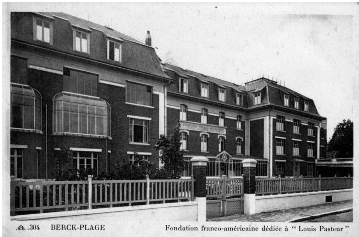
Hôpital Pasteur ou Fondation franco-américaine - Elévation antérieure. Carte postale, 2e quart du 20e siècle.
