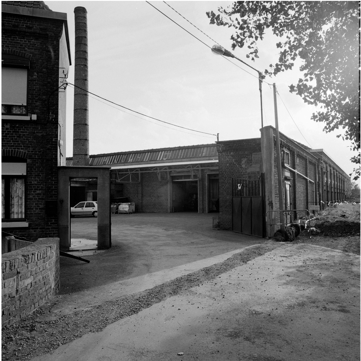
Entrée, élévation ouest.
