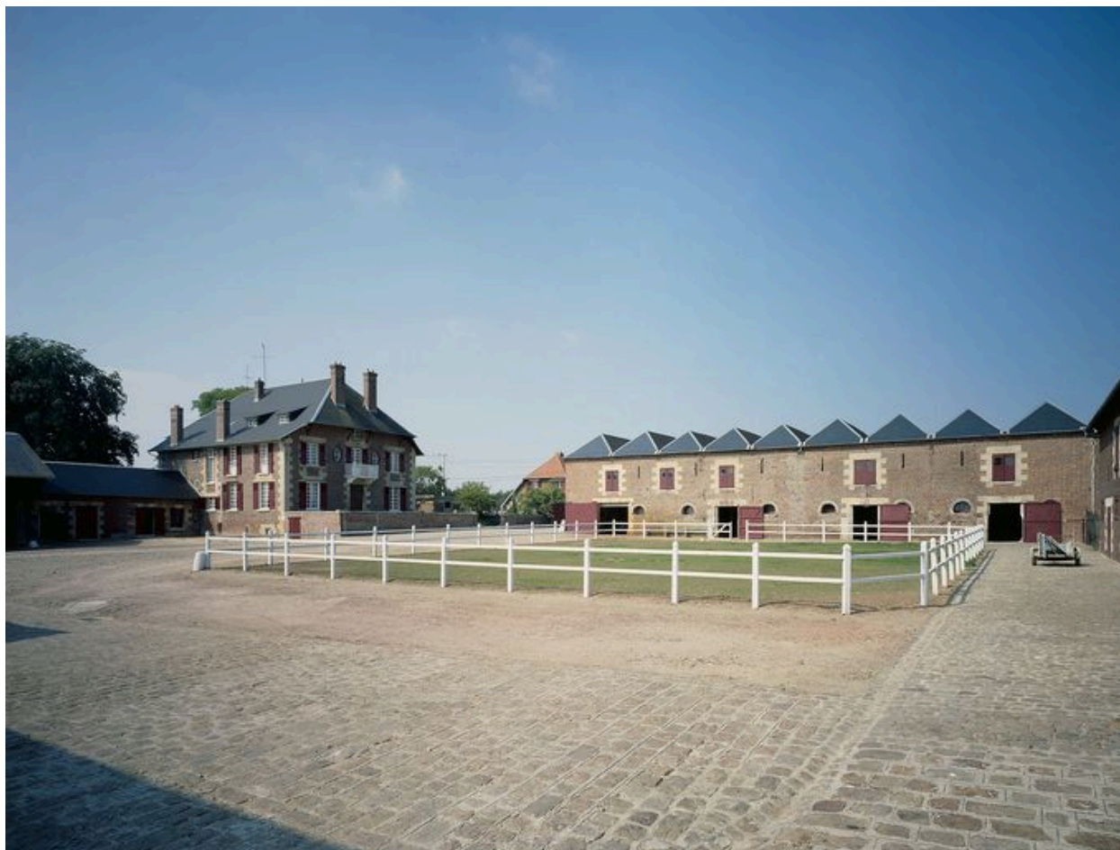
Vue générale de la Ferme Neuve.
