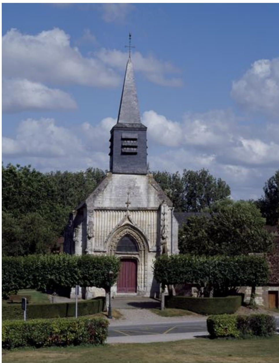
Vue de la façade occidentale.
