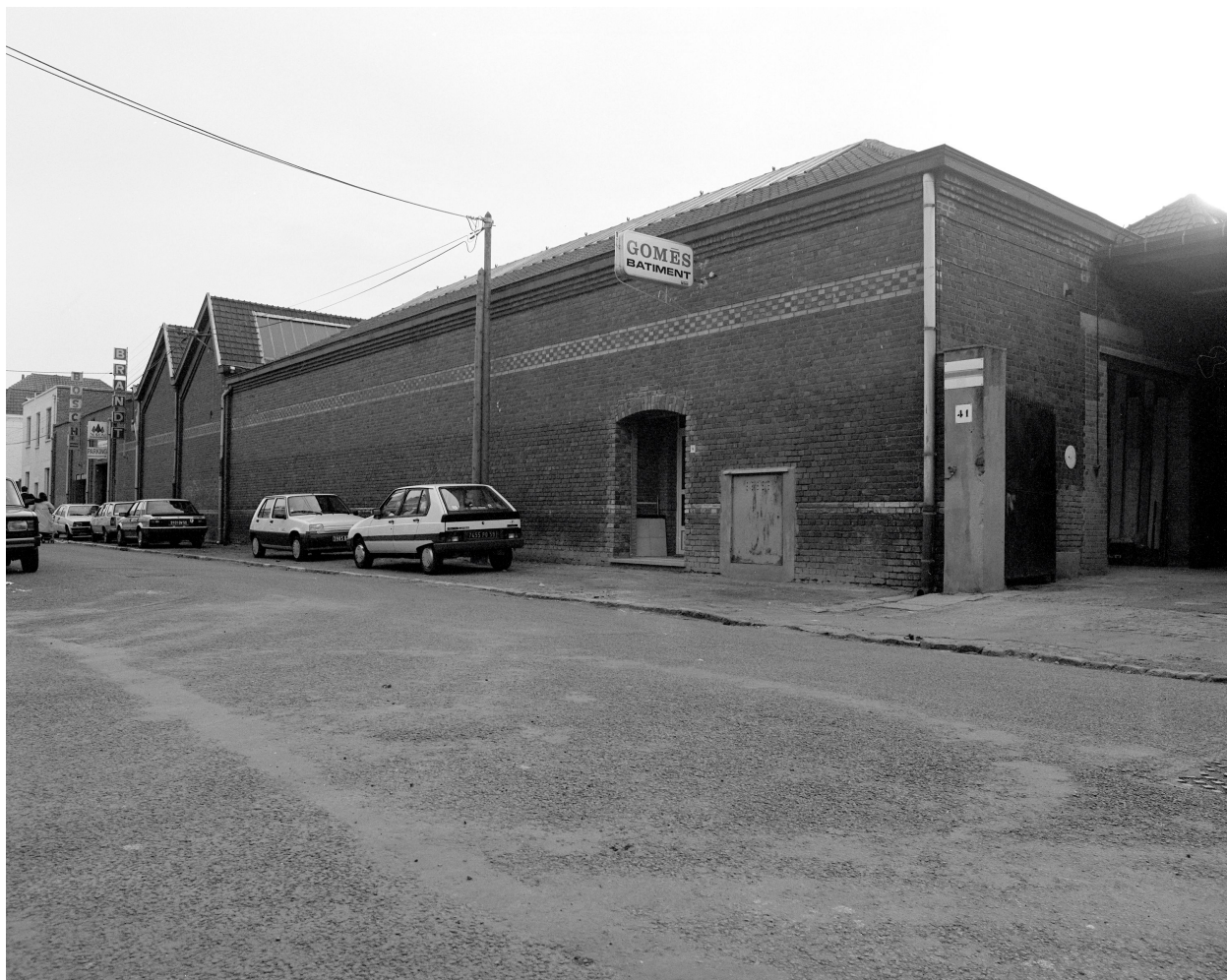
Élévation rue Voltaire, vers le sud.
