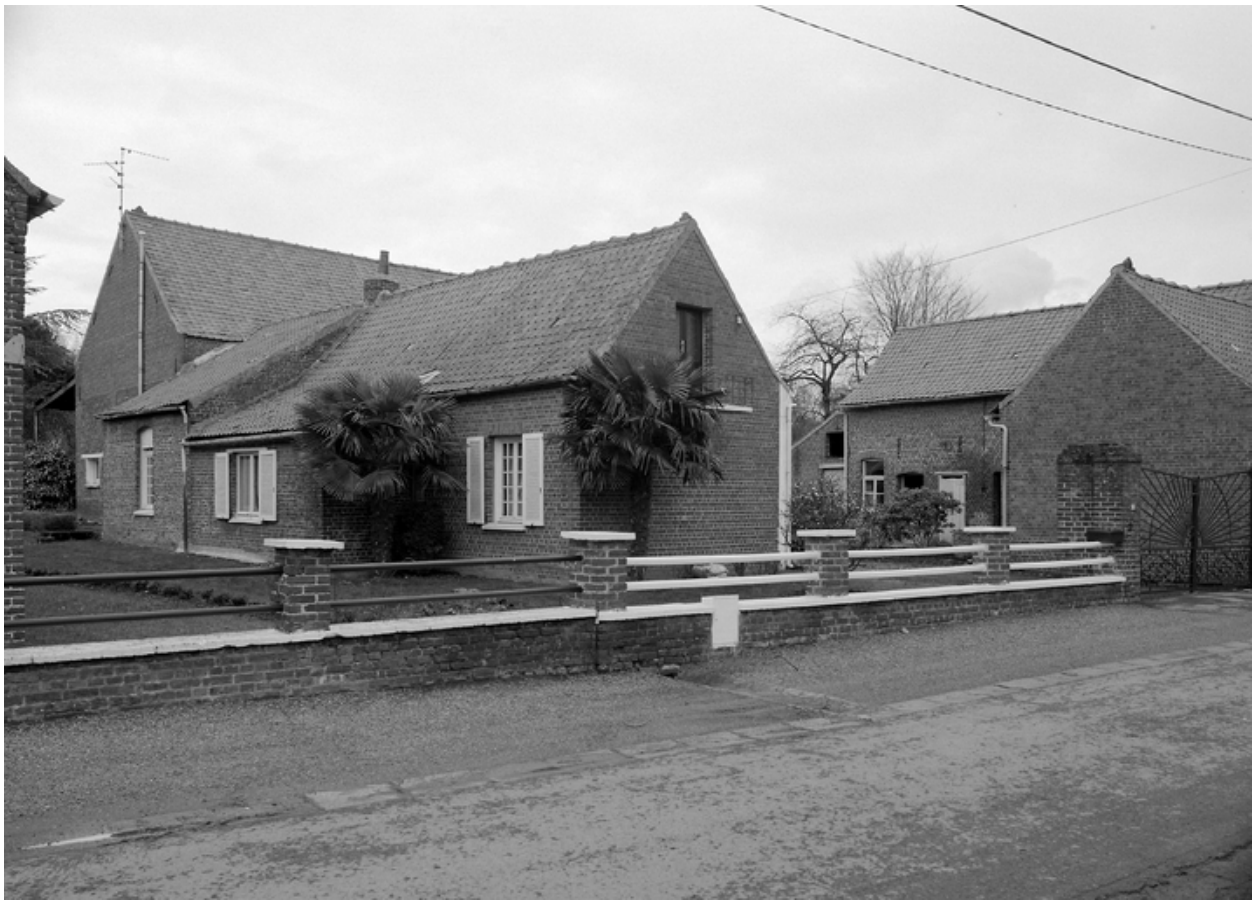
Ferme partiellement reconstruite après la Seconde Guerre mondiale, 318, rue de la Cloyère, vue générale.
