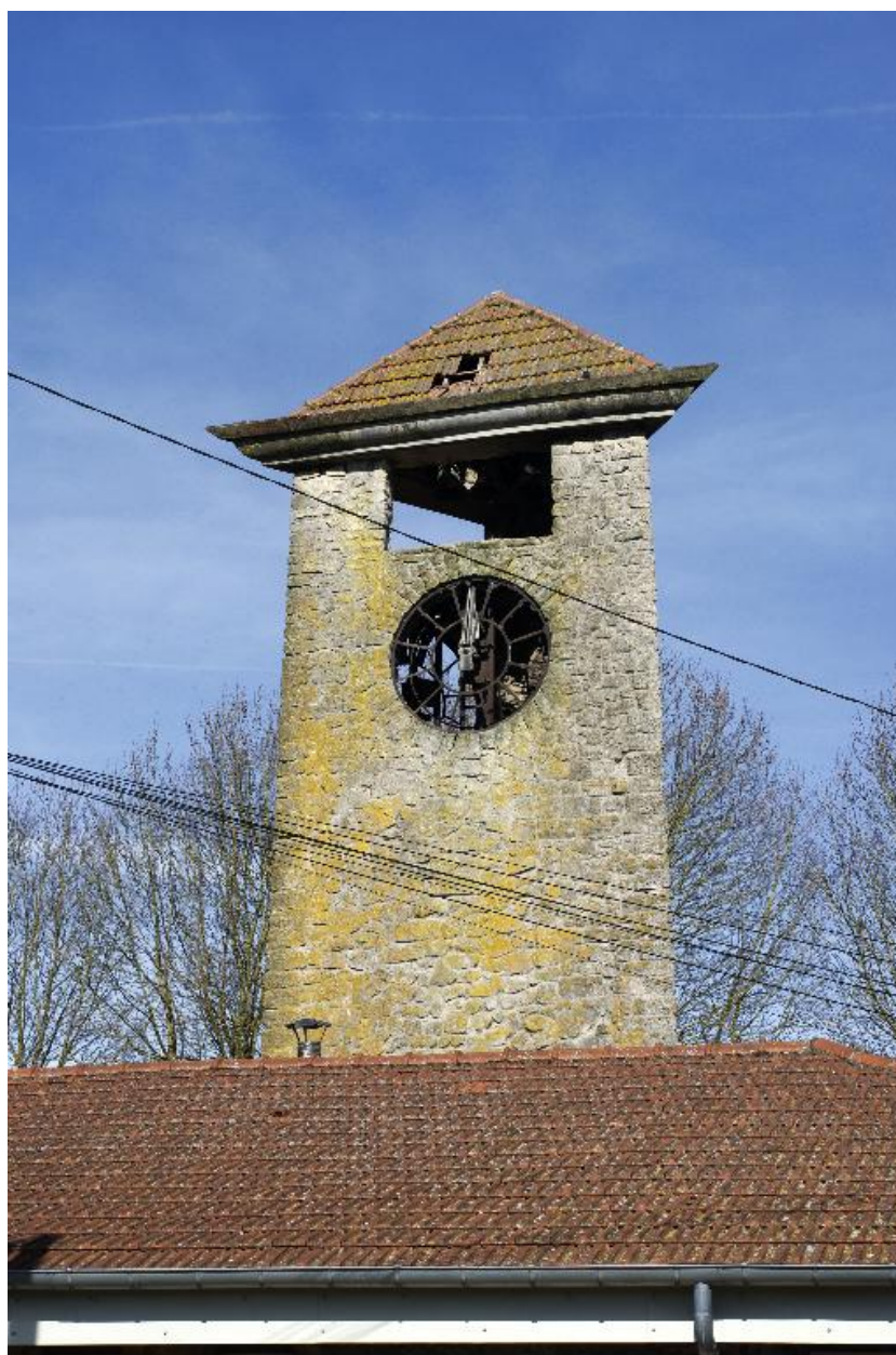
Détail du clocher de l'école.
