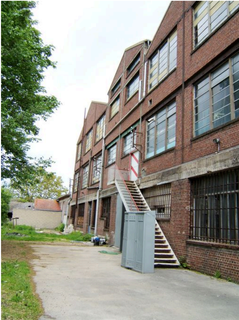
Vue latérale de la façade ouest.
