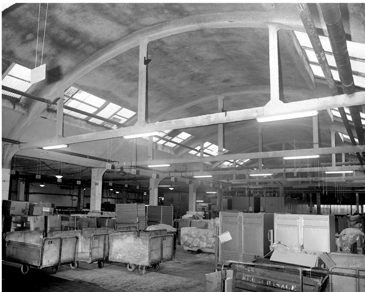
Atelier de fabrication. Vue intérieure.
