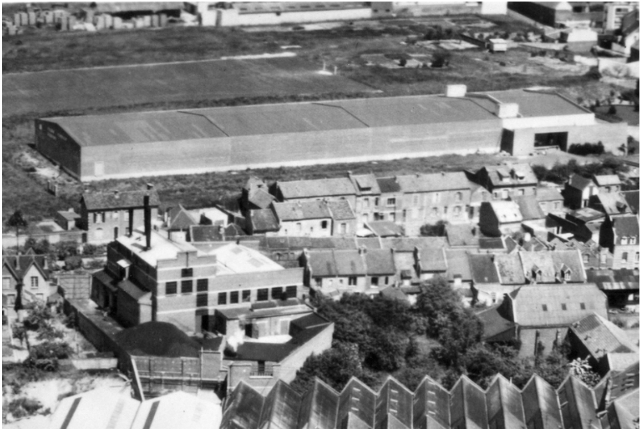
Vue aérienne de la filature lors de la construction, vers 1957-1962. Au premier plan, l'usine de caoutchouc Boinet (AD Aisne).
