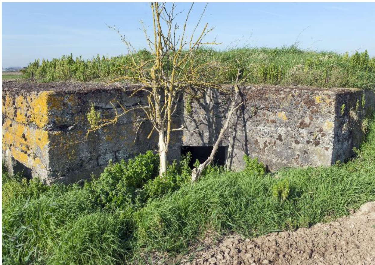
Entrées est et sud-est
