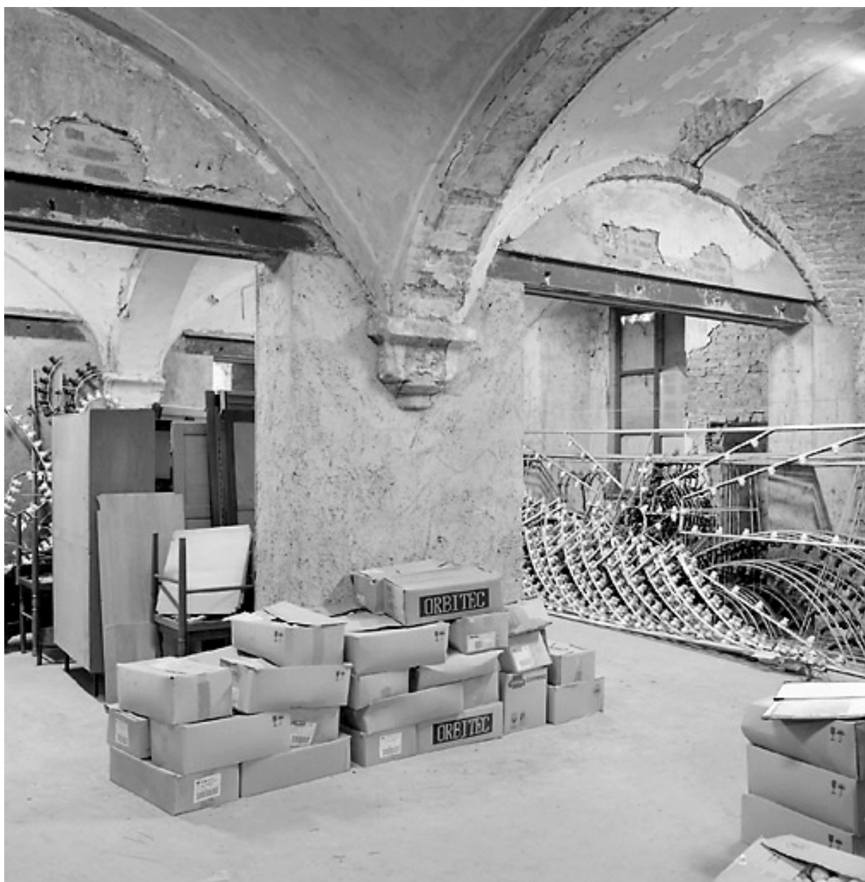
Intérieur, rez-de-chaussée, vue partielle : salle conventuelle, état en 2005.
