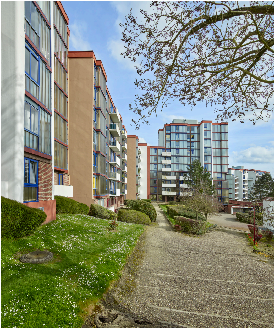
Cheminement vers le bâtiment D (escaliers pas d'âne), vue prise depuis l'ouest.
