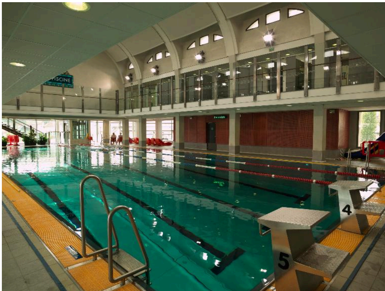
Vue générale du bassin sportif, détail des tremplins. A l'étage, se trouvent les vestiaires.
