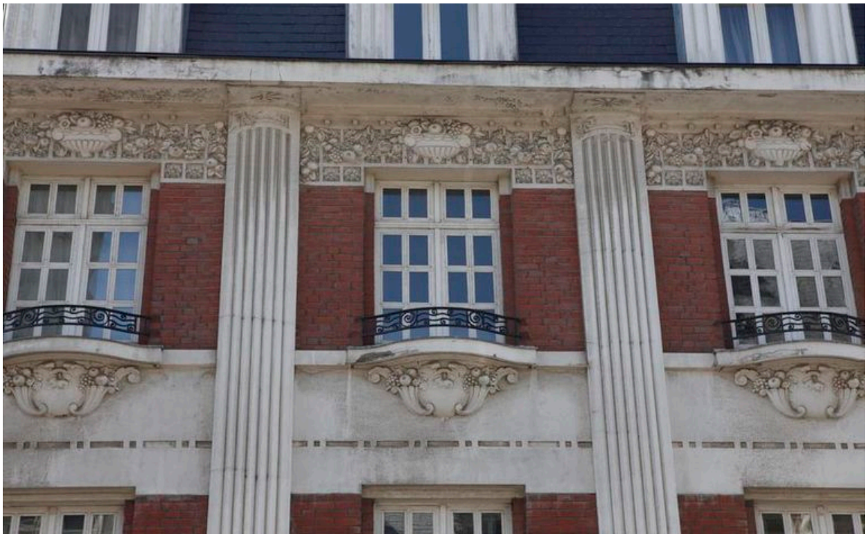
Vue de détail des baies du second étage-Frise et appuis de baies sculptés de fleurs et de motifs Art déco.
