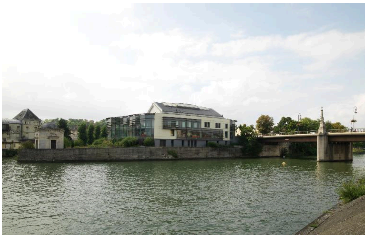
La pointe de l'Île-Saint-Maurice : façade nord de la piscine, pavillon du XVIIIe siècle, et pont; vue depuis le quai d'Amont.
