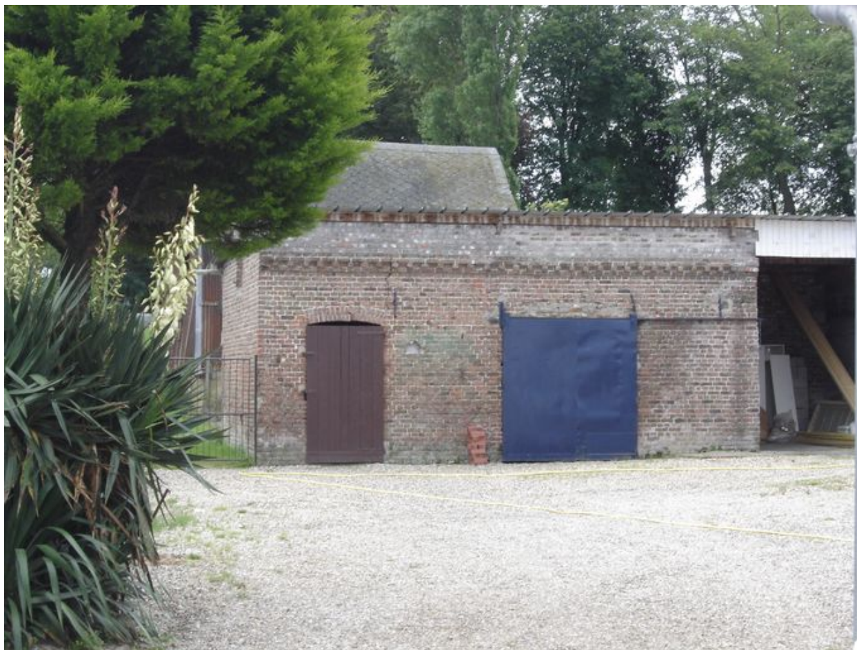
Vue de la remise située au fond de la cour.
