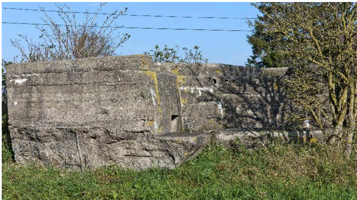
Vue de trois-quarts, vers le nord-est
