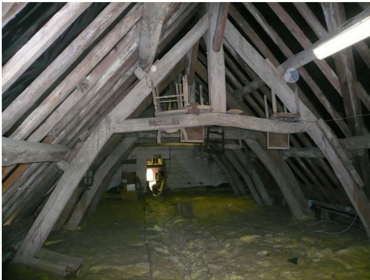
Vue de la charpente du logis.
