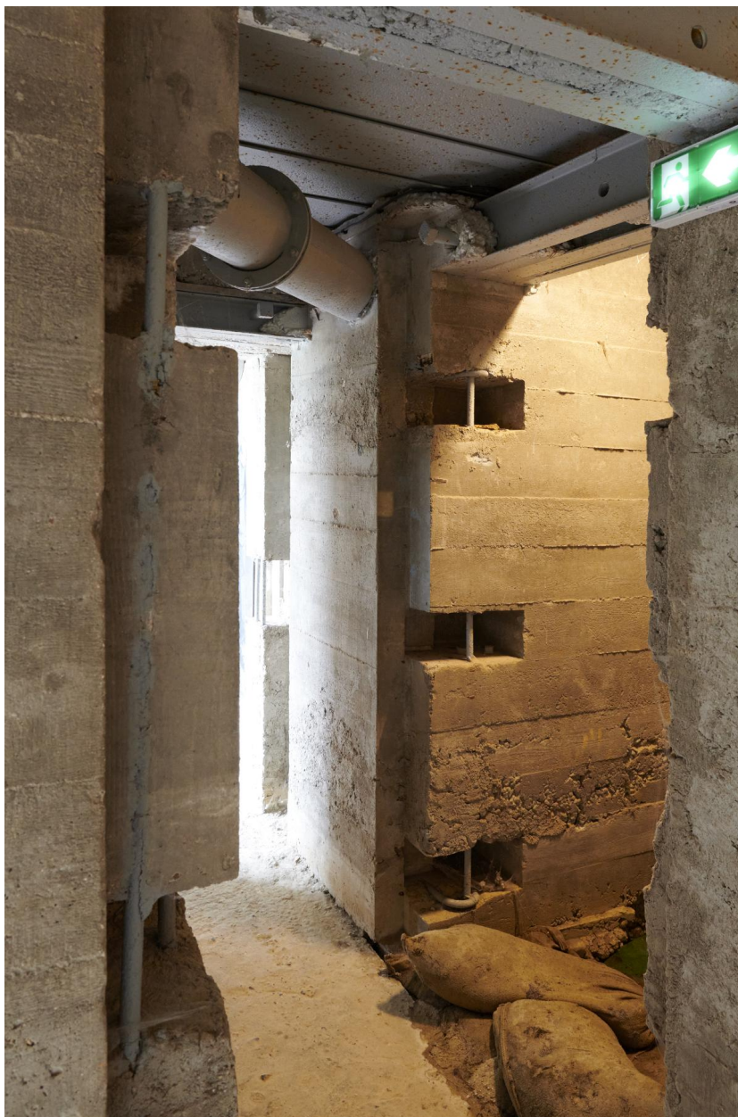
Vue intérieure de la casemate. Couloir, sas d'entrée.
