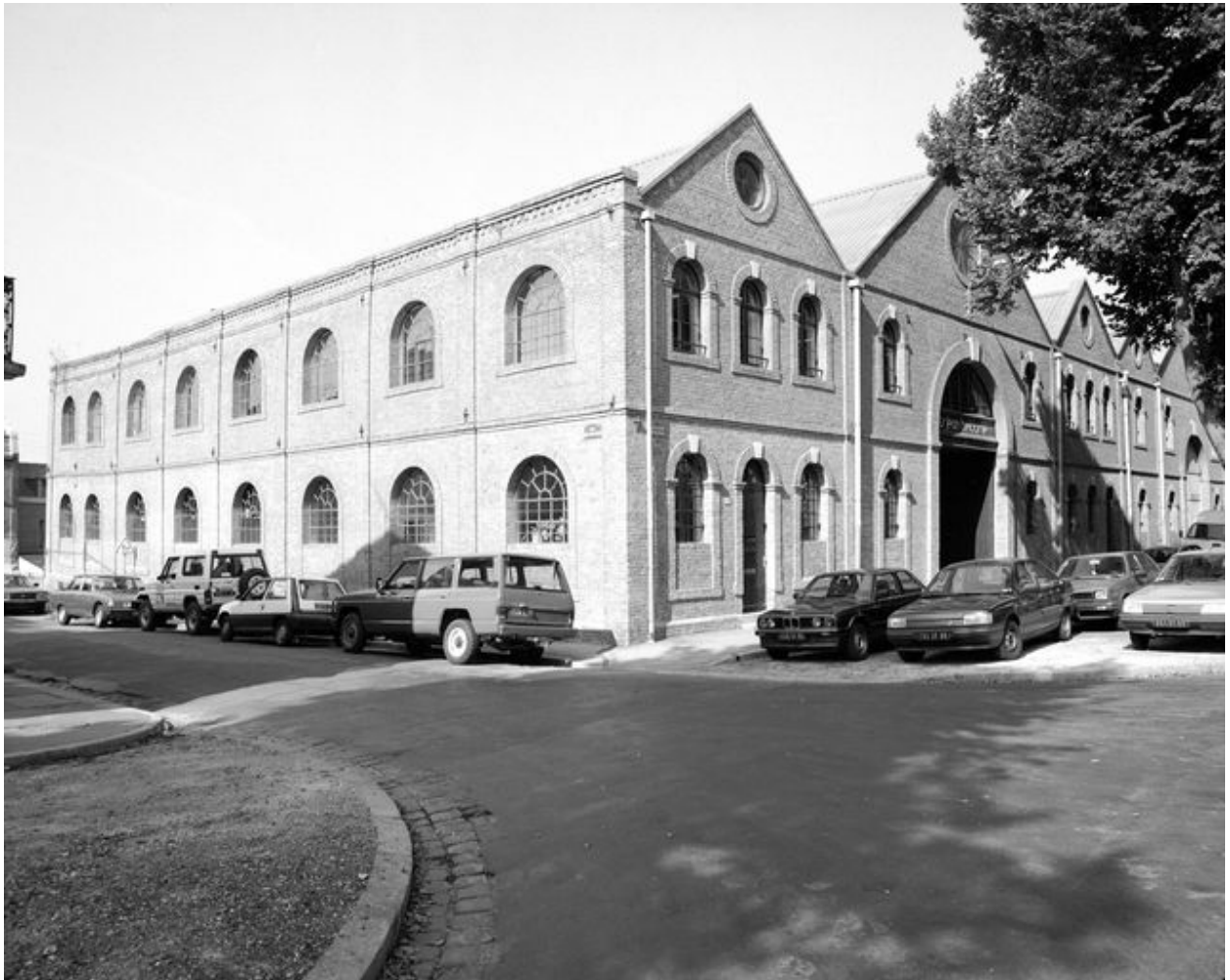
Atelier de fabrication, élévation sud-est.
