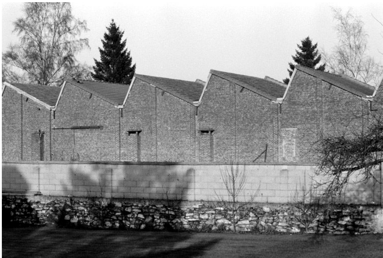
Vue du magasin d'usine textile.
