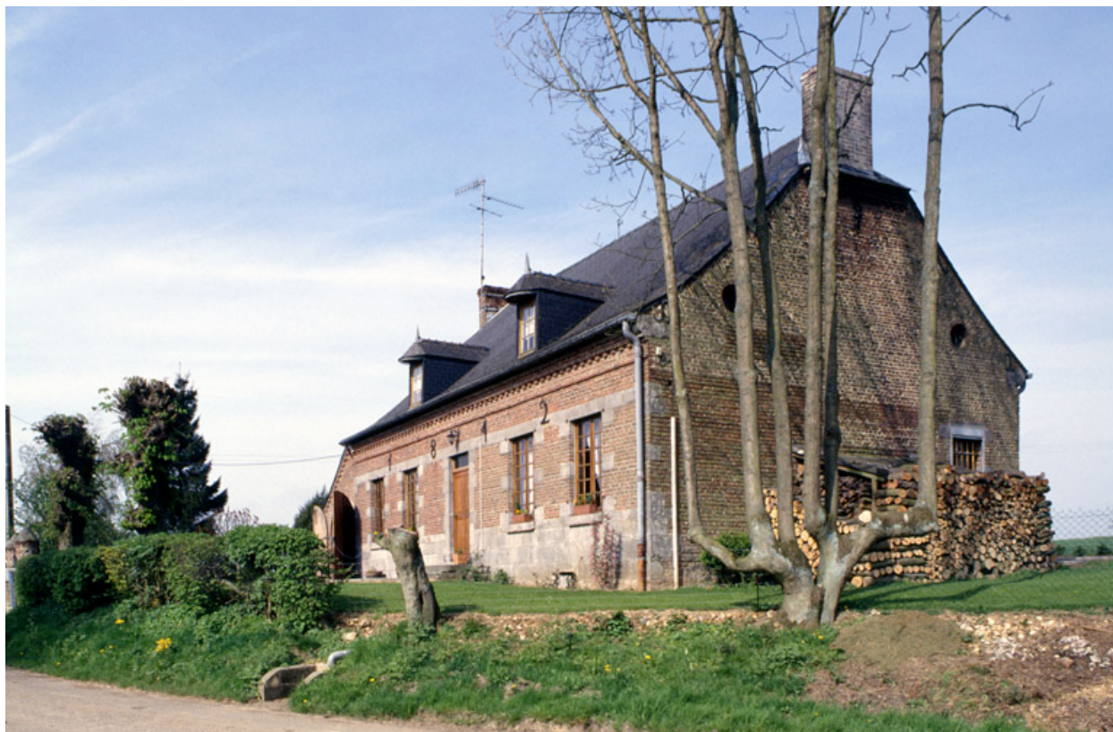
Vue de trois-quarts depuis l'est.
