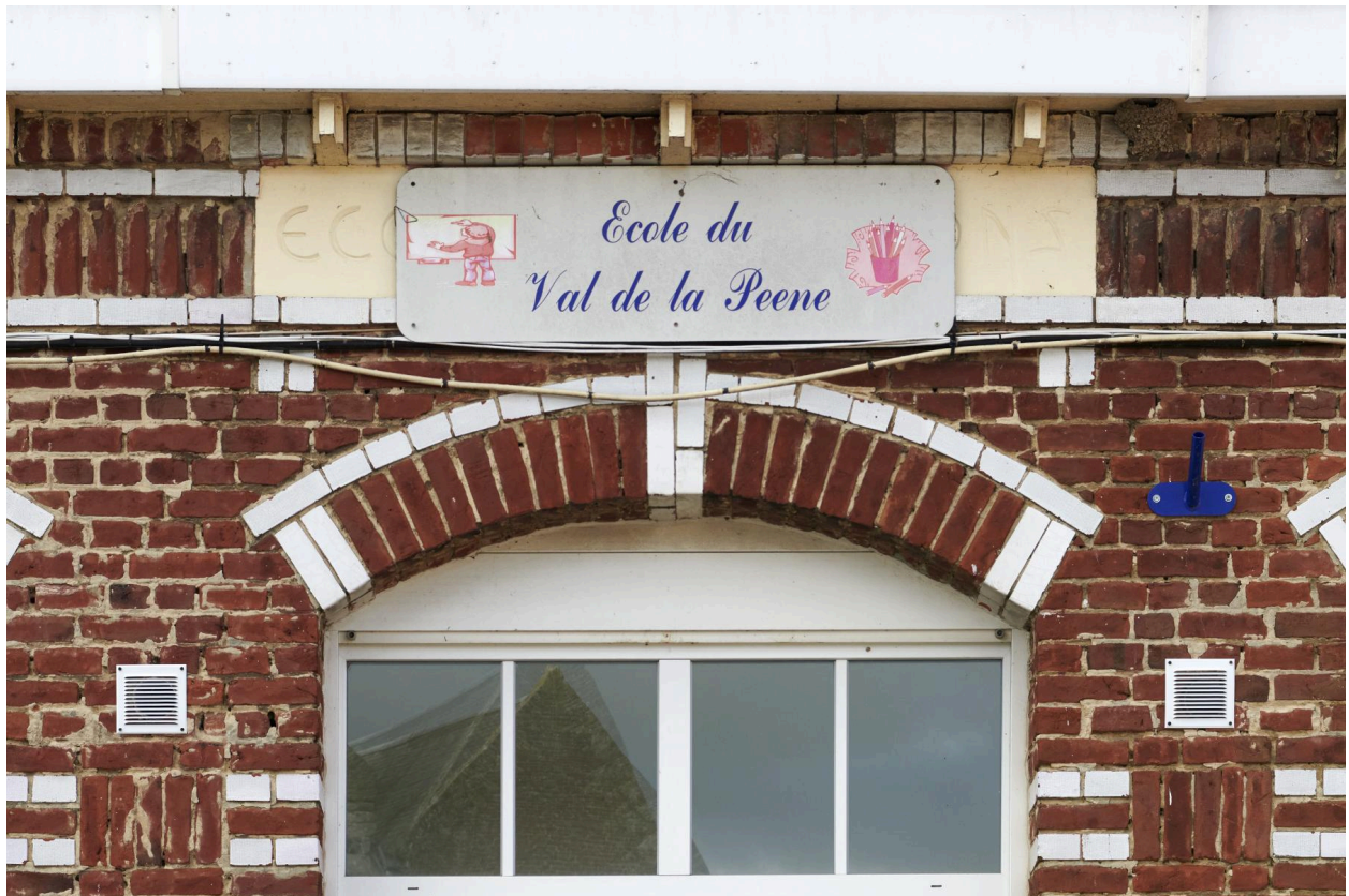
Détail de la façade sur rue.
