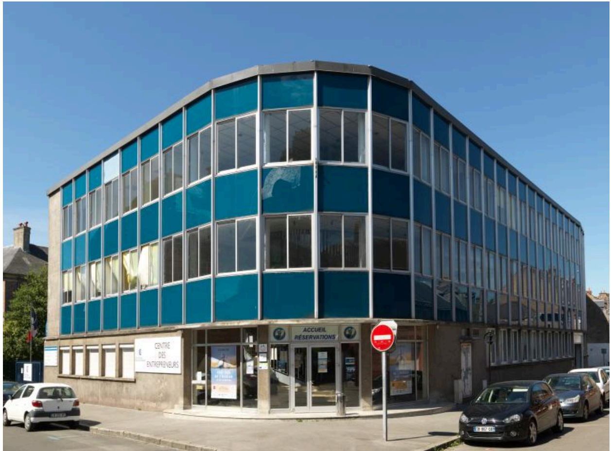
Immeuble de bureaux de la chambre de commerce. Vue depuis le carrefour des rues du Chevalier-de-la-Barre et des Grandes-Ecoles.
