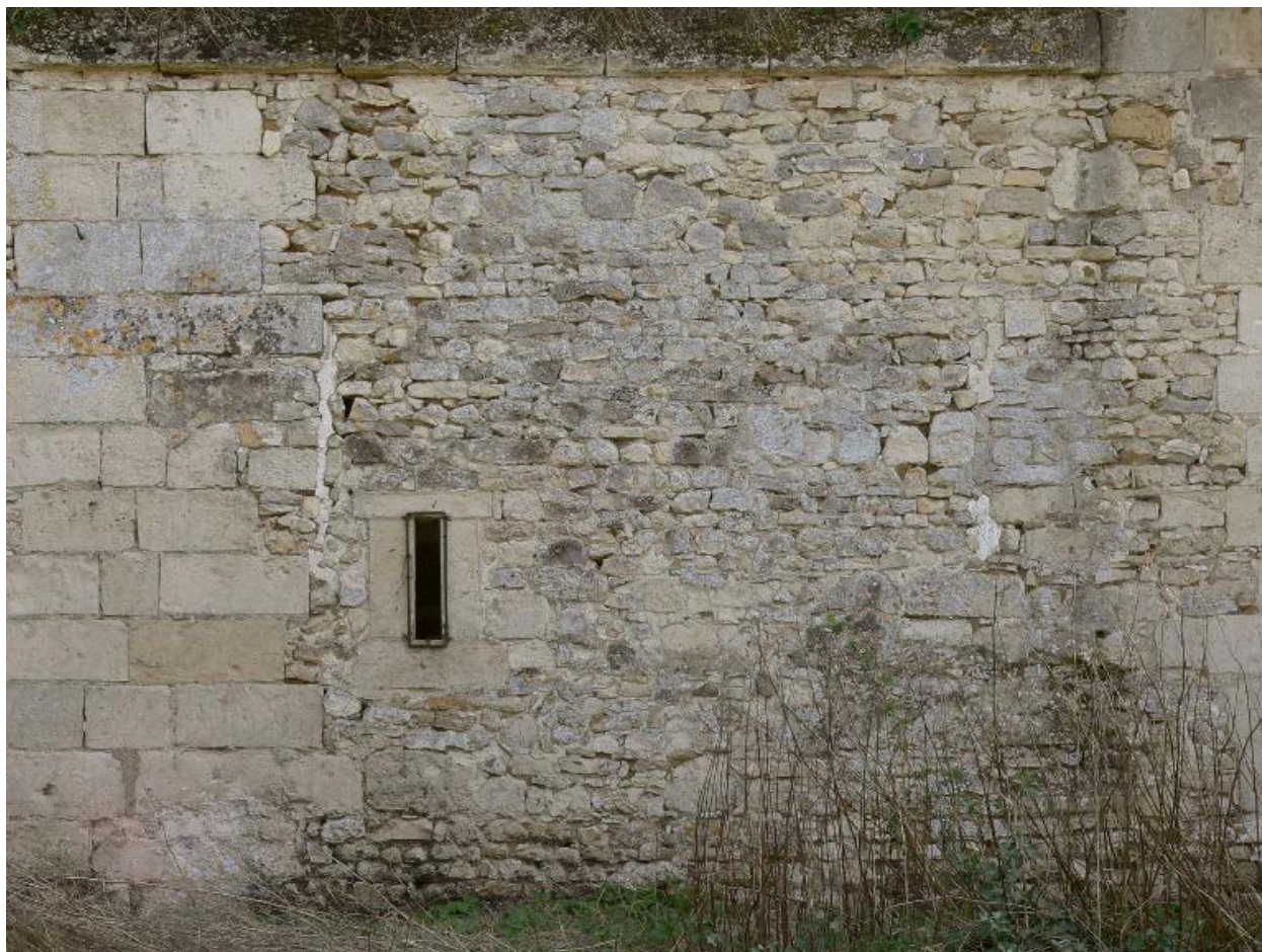
Détail de la maçonnerie du mur d'enceinte nord-ouest.
