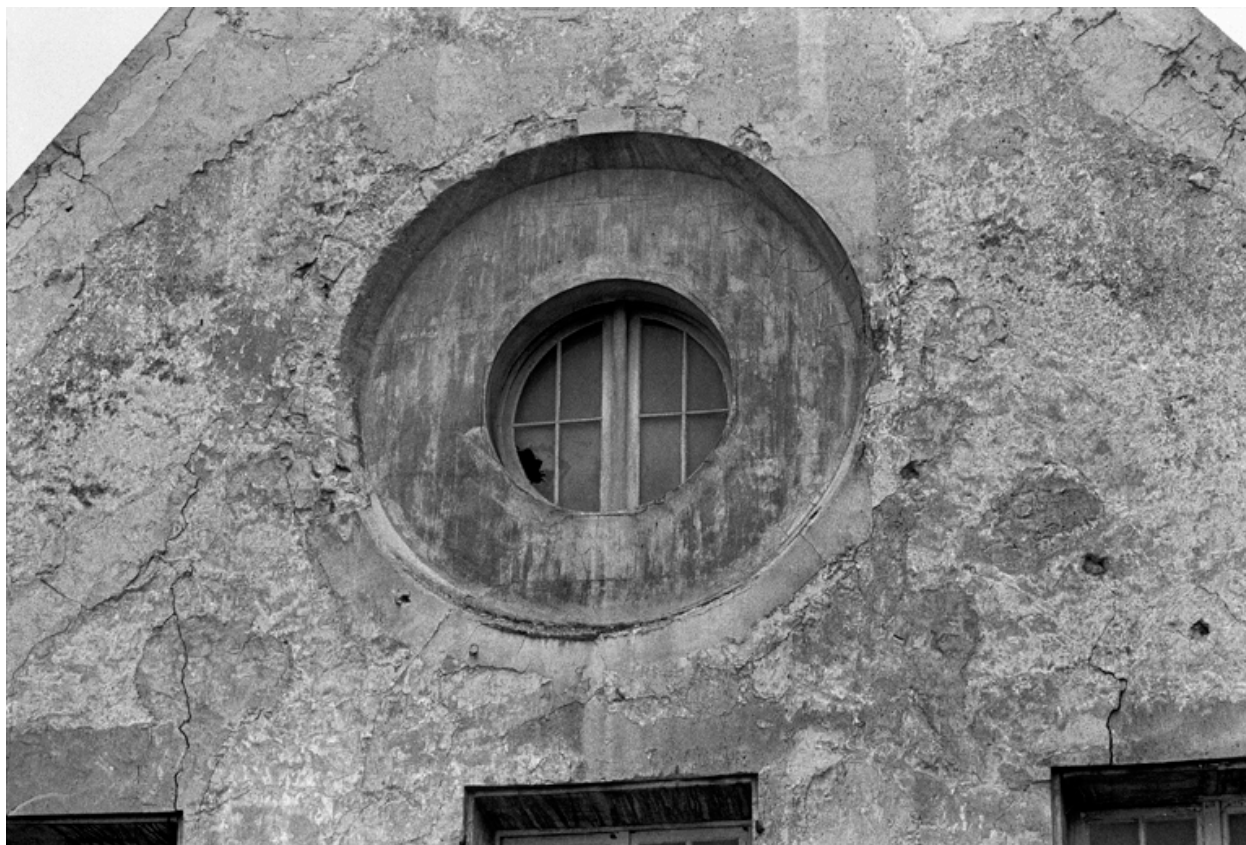
Détail de l'oculus et vue de la façade ouest de la chapelle.
