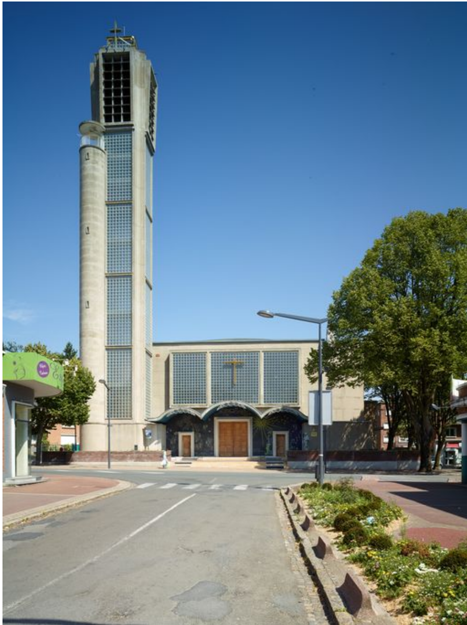
Élévation antérieure de l'église.
