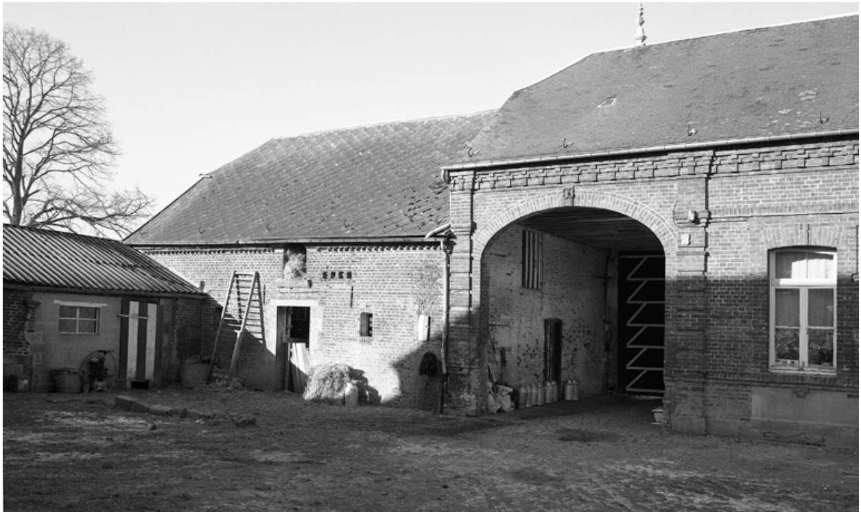
Élévation sur cour du logis et de l'étable voisine.
