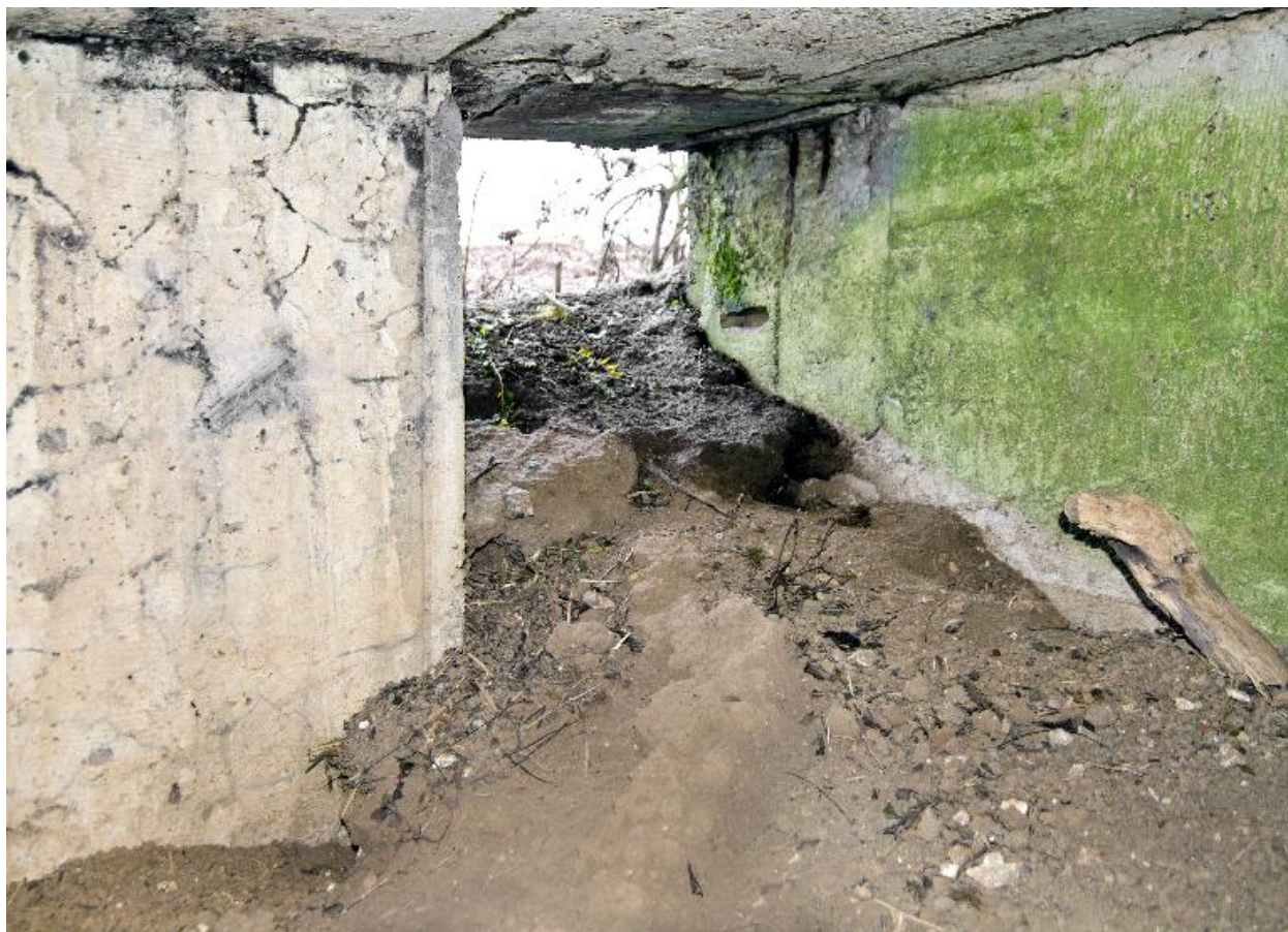
Couloir sud, vers l'extérieur
