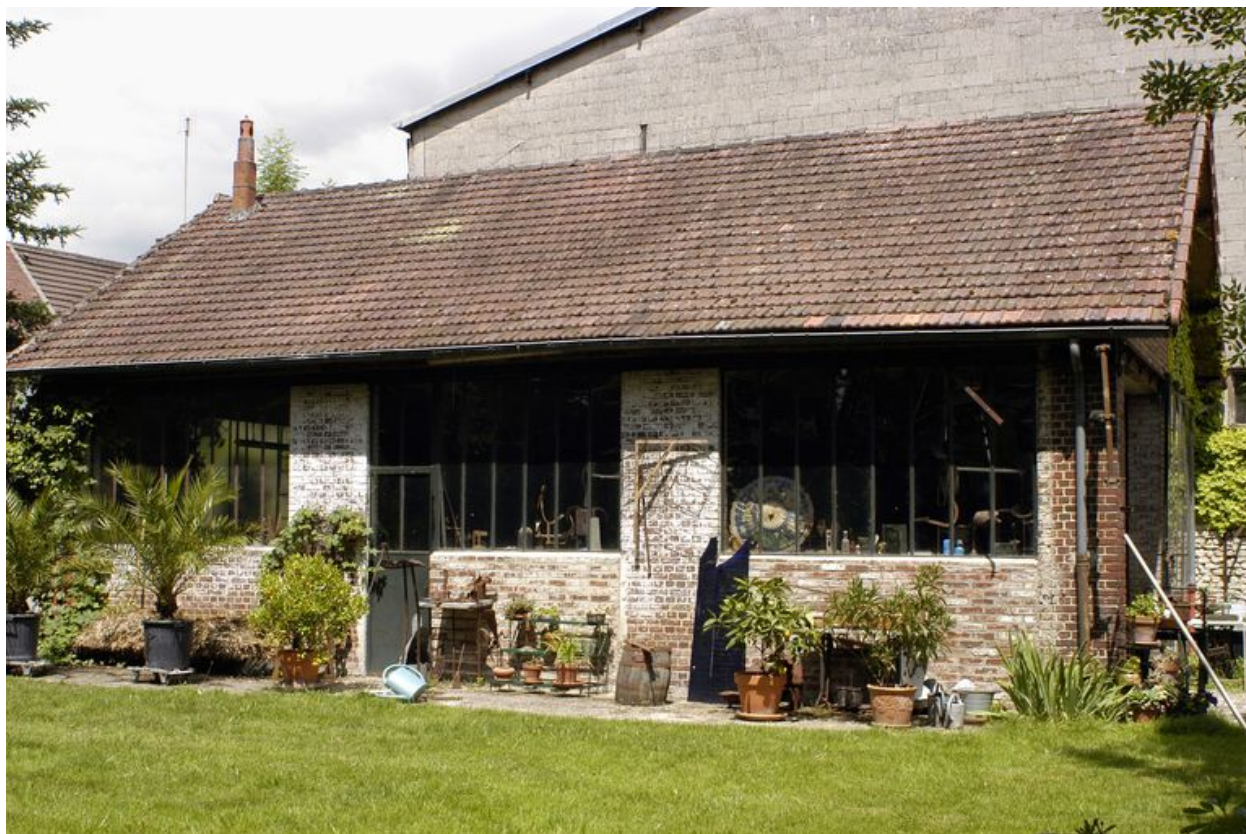
Atelier de montage des brosses, vue d'ensemble.
