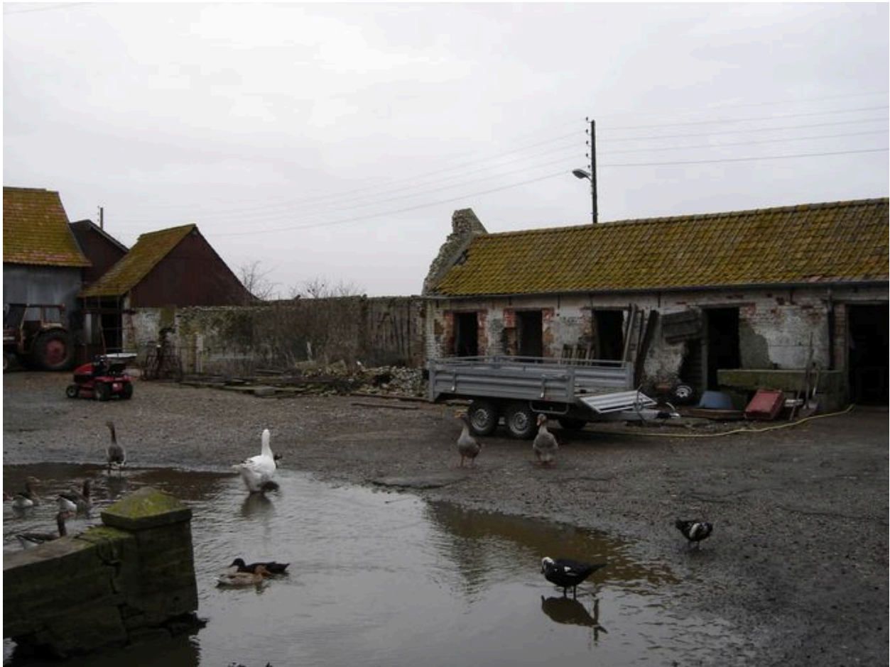
Vue depuis la cour des bâtiments bordant le côté nord de la cour.
