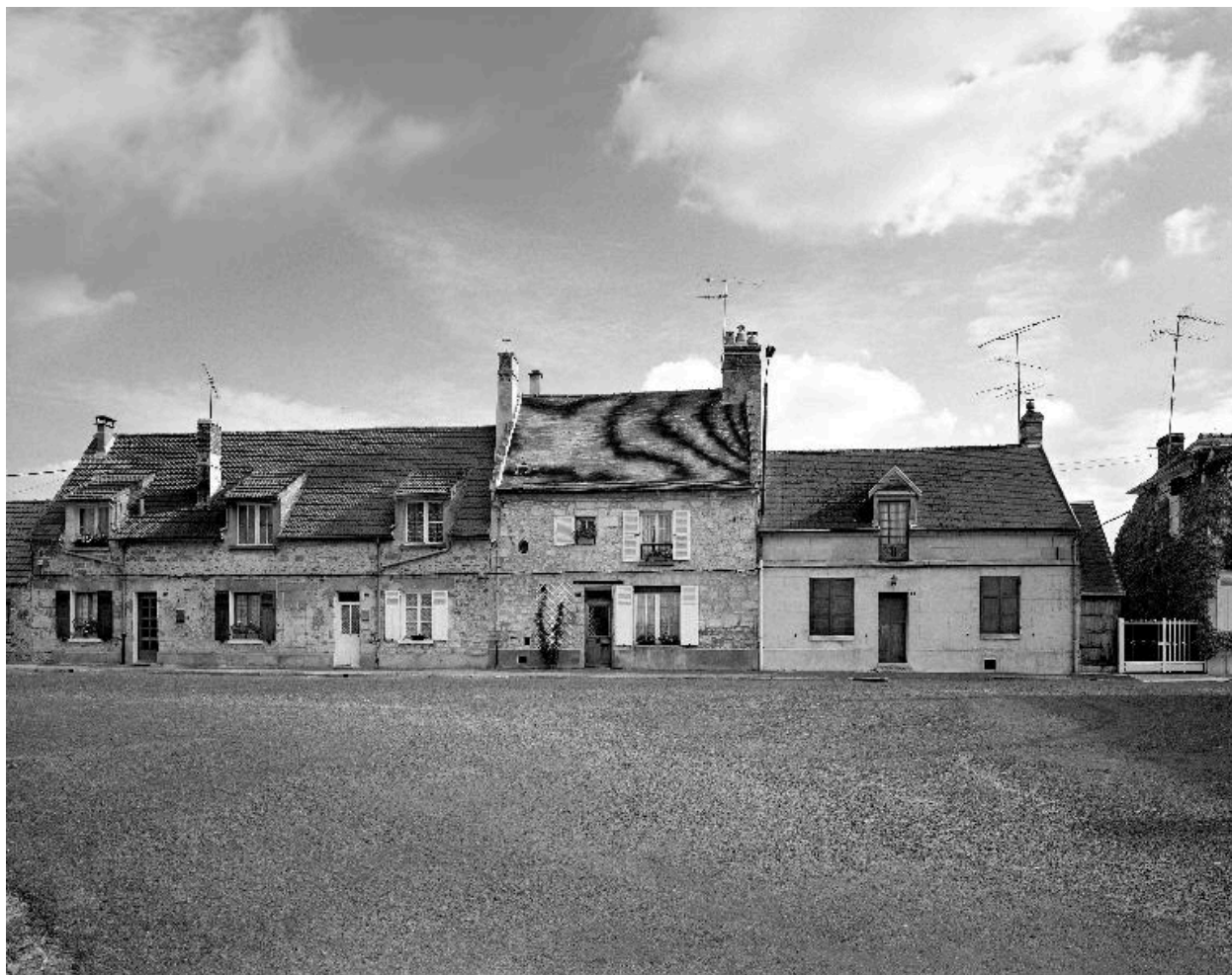
Façade des maisons alignées au sud-est de la place de l'Église.
