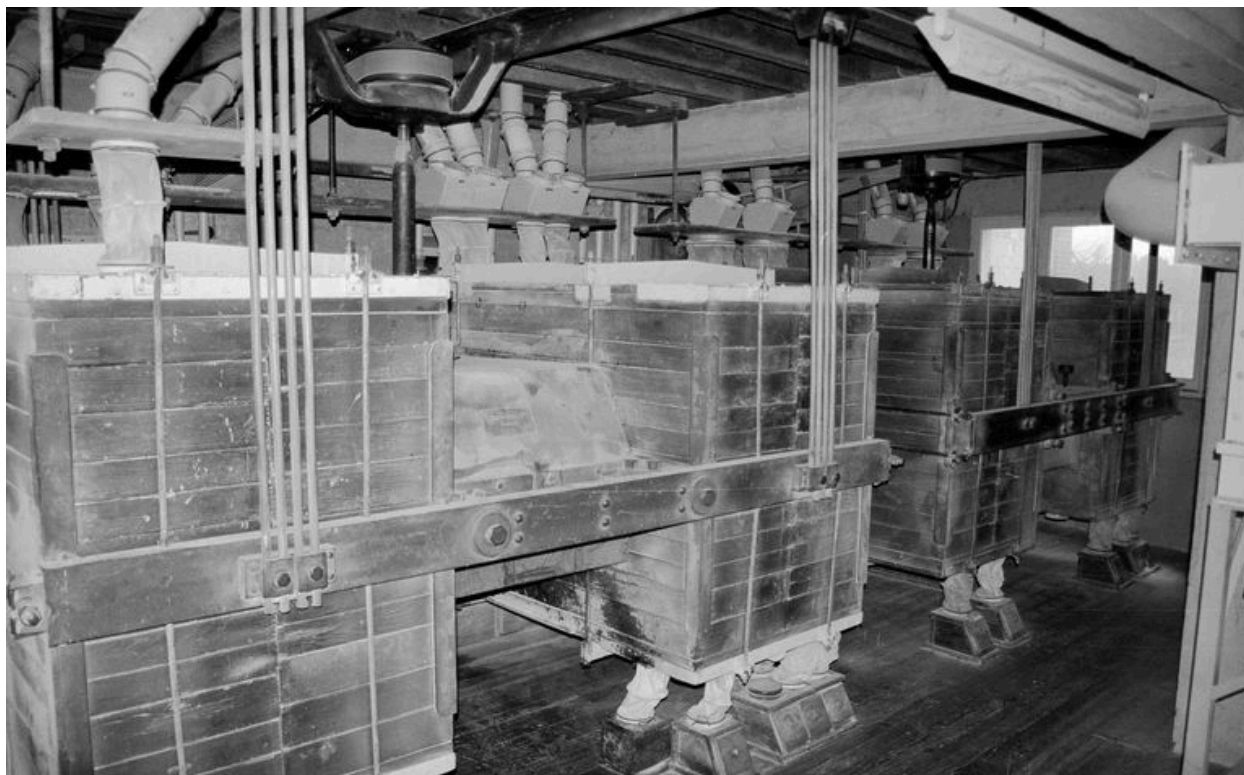
Vue intérieure du 2e étage de la minoterie, vue des planchisters.
