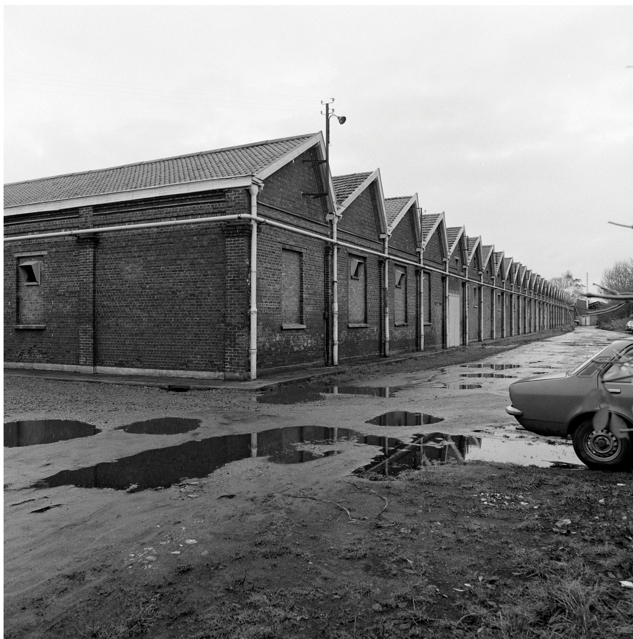
Atelier de fabrication, élévation sur cour.
