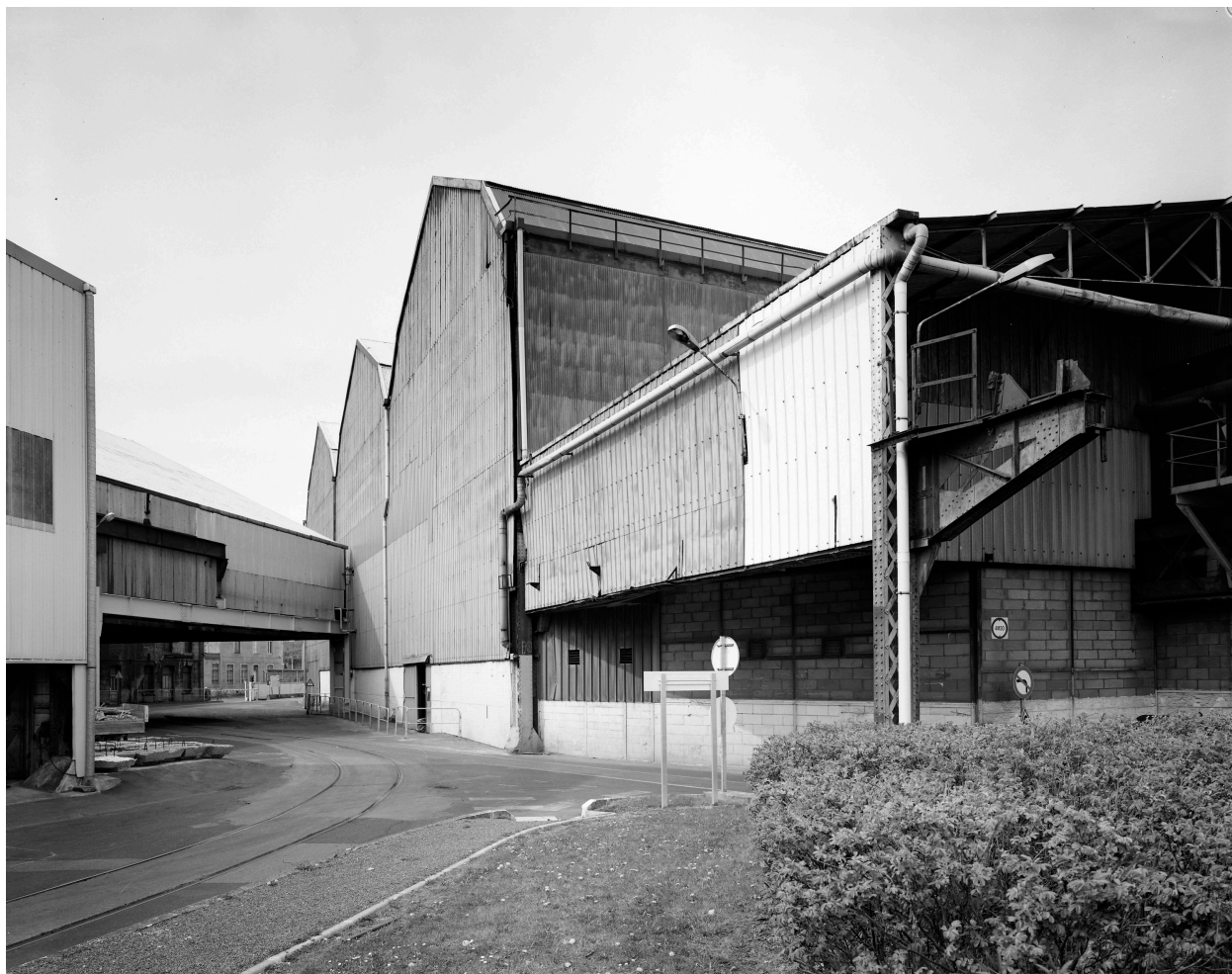
Vue générale du pignon des anciens laminoirs dans lesquels est installée la ligne II (galvanisation et peinture des tôles).
