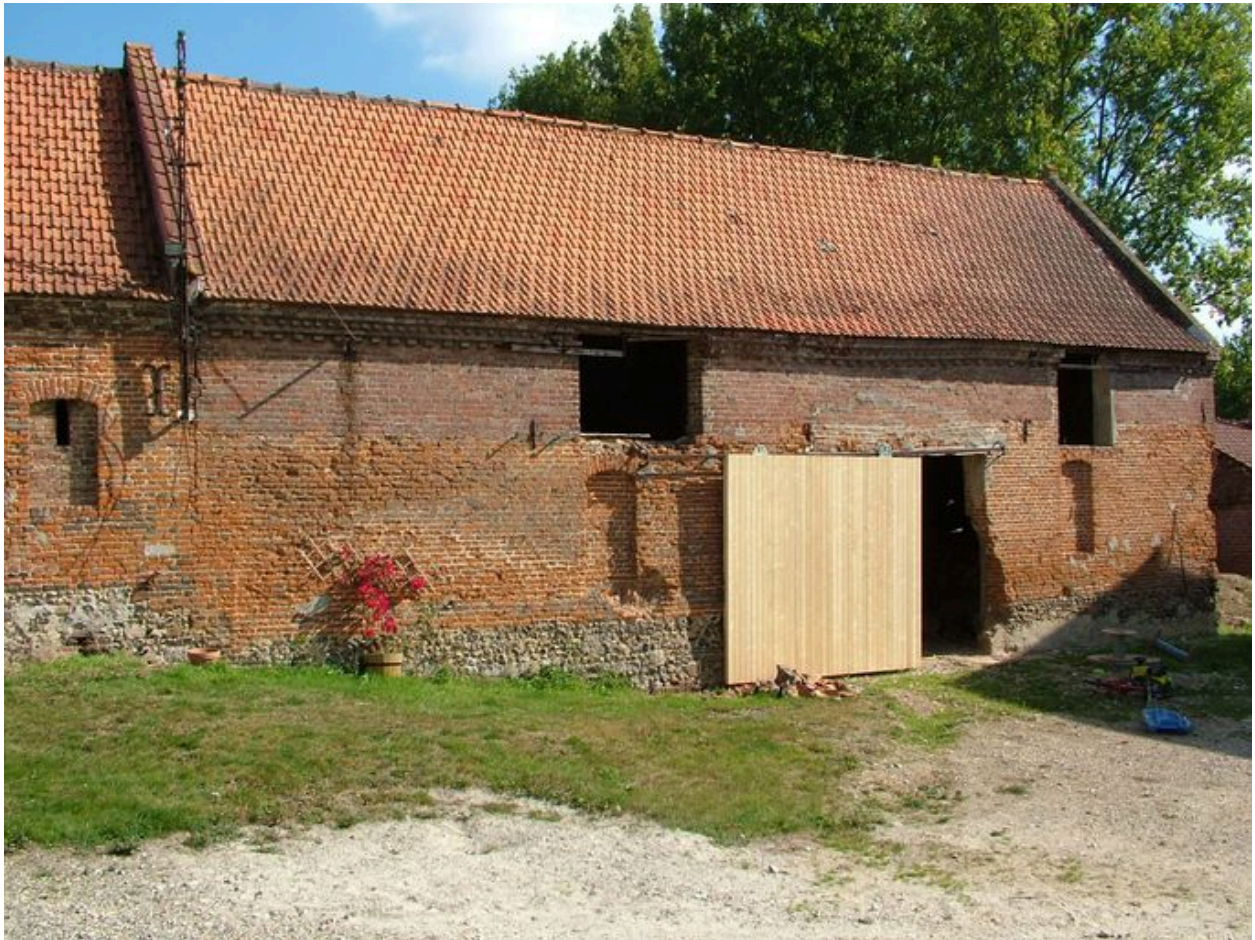
Vue de la remise à l'est.
