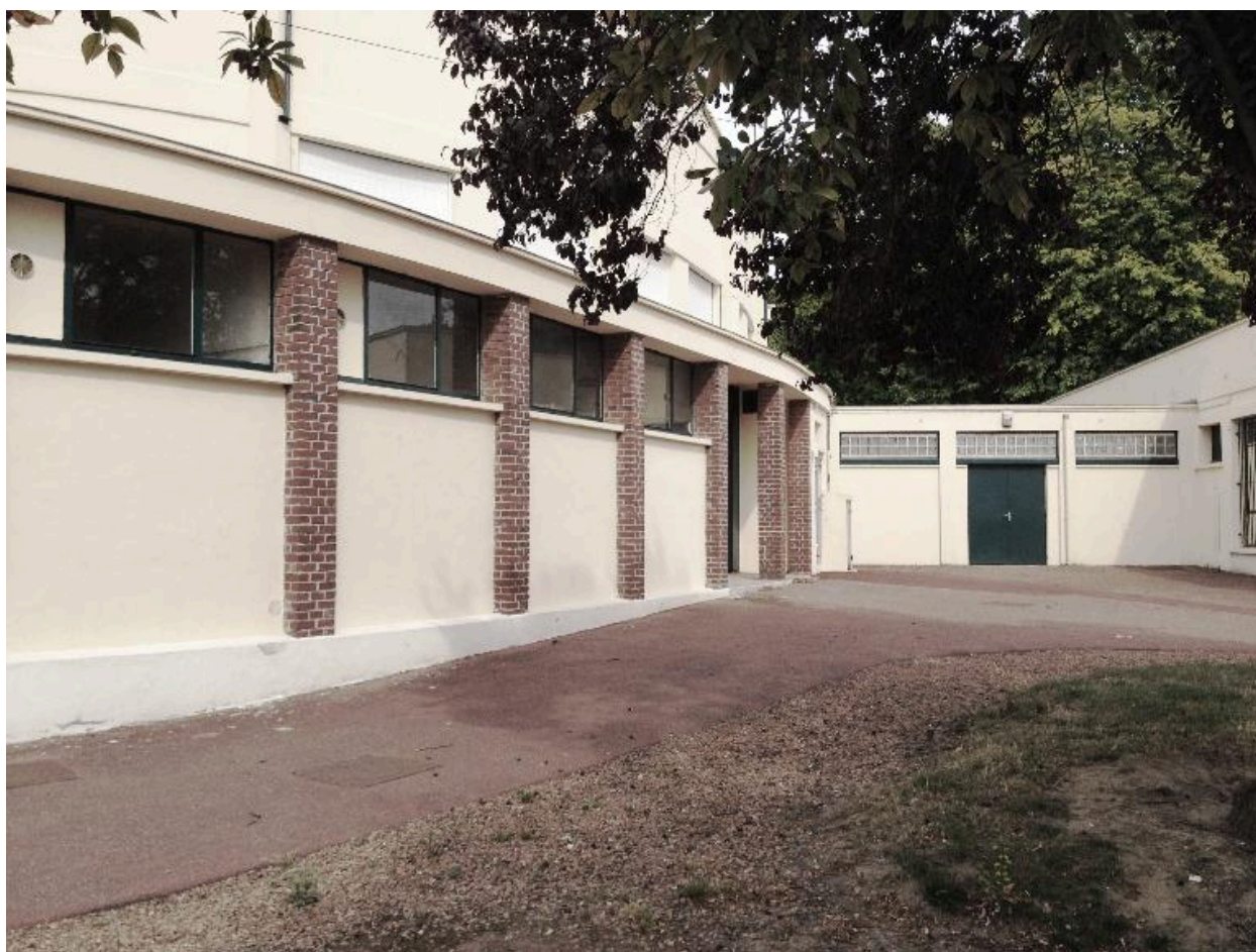
La salle des fêtes. Vue de la façade sud.
