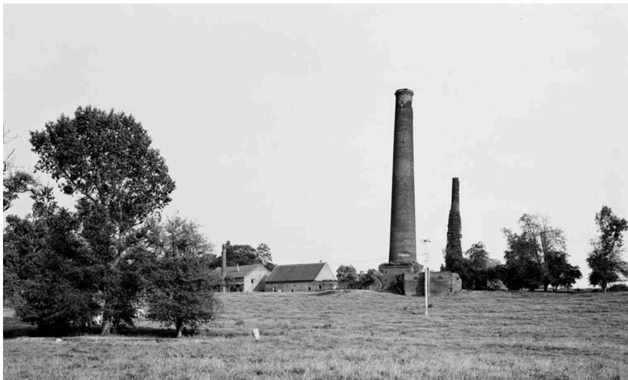
Vue générale nord.
