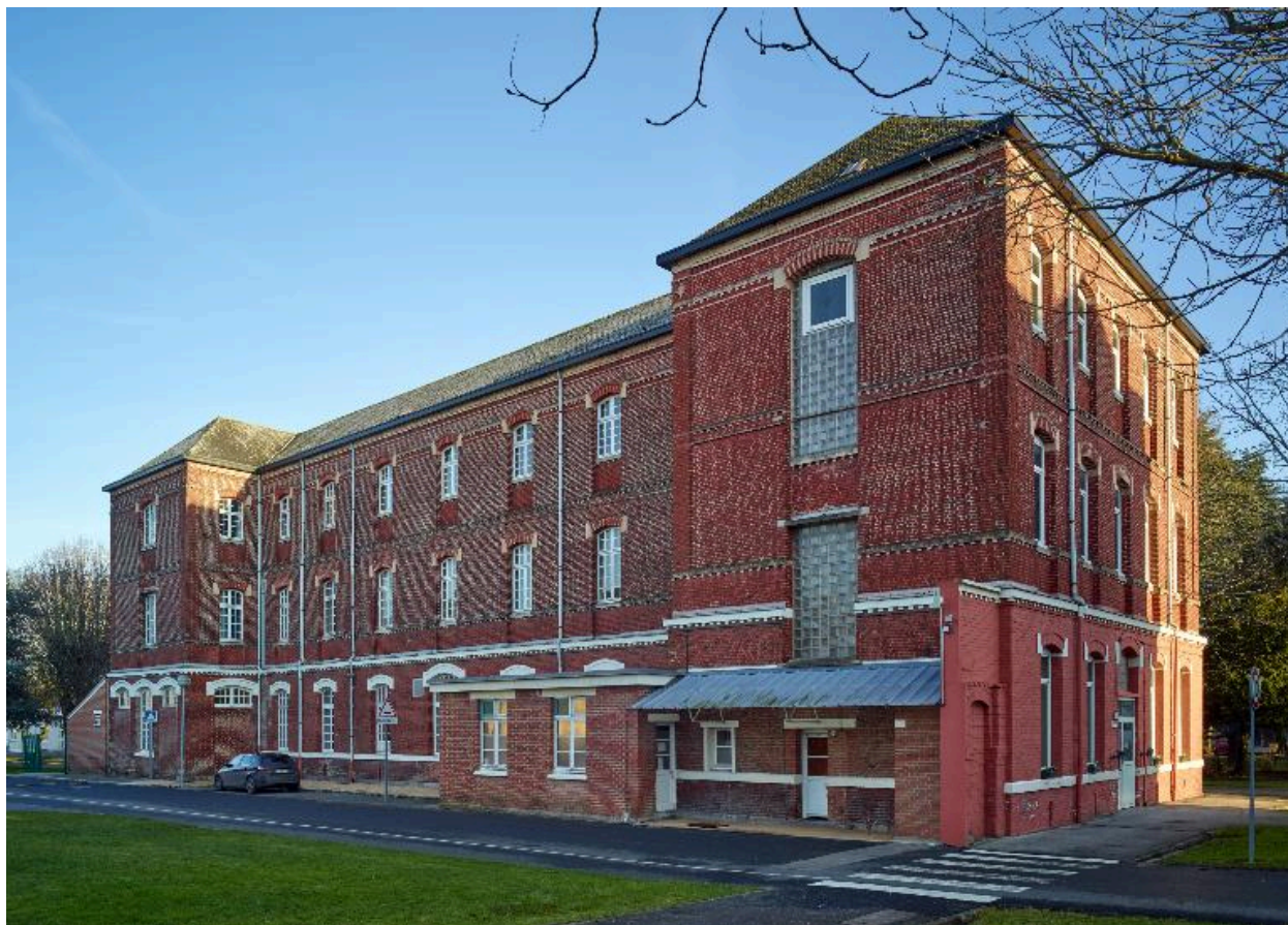
Bâtiment d'hospitalisation dit pavillon 2, élévation postérieure, vue générale prise de trois quarts droit.
