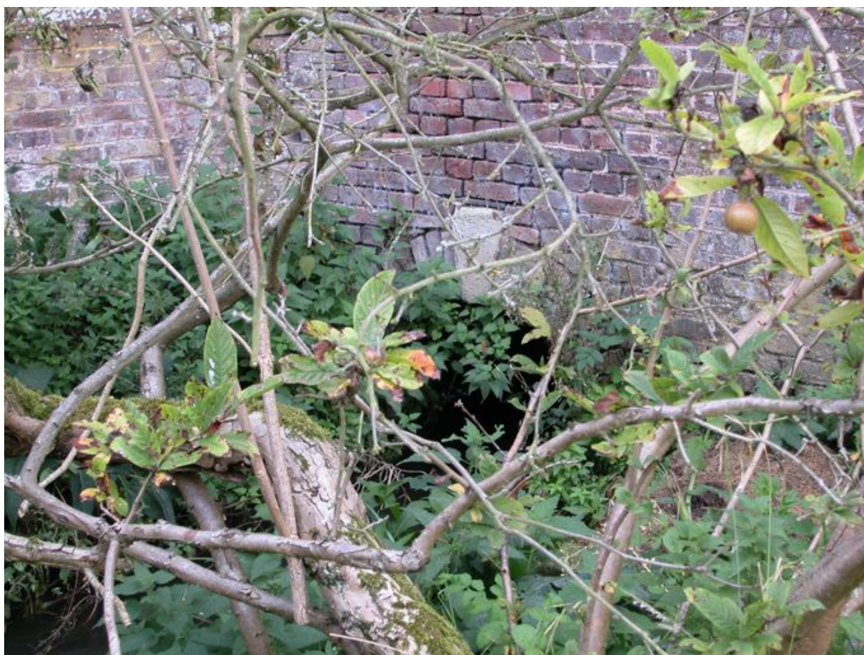
La sortie du canal de fuite.
